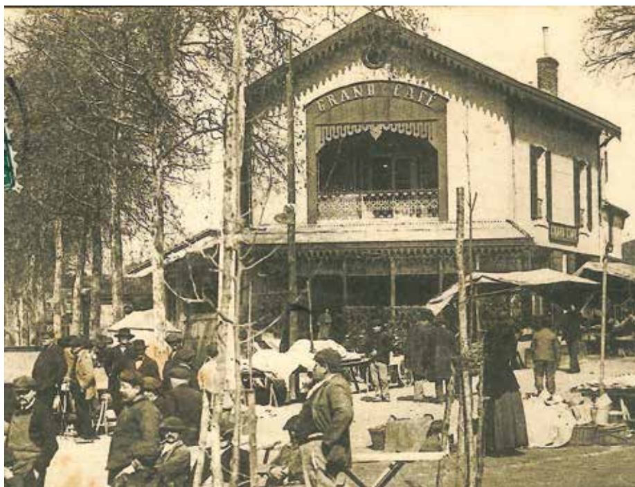
Poteaux de soutènement de la marquise identiques à celui retrouvé à l'intérieur du bureau de poste.
