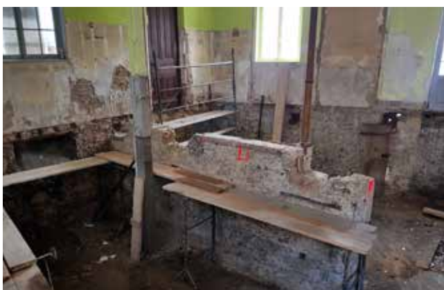
Destruction du plancher béton
